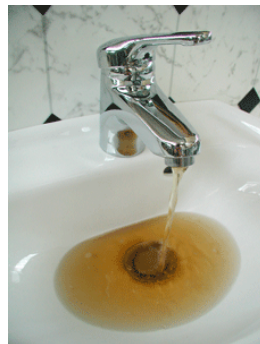
JUDO-Werksbild Braunes Wasser einer vor Lochfraß und Rost ungeschützten Hauswasserinstallation
