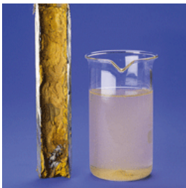
Lochfraß, Rost und braunes Wasser in einer nicht geschützten Anlage.
