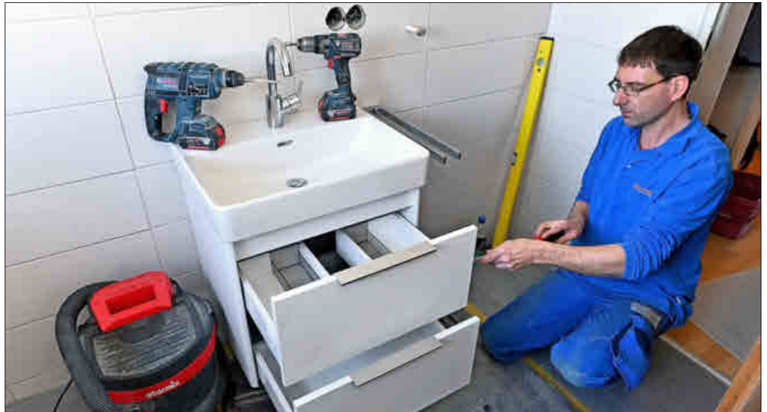
Modernes Weiß, glänzende Armaturen – hier entsteht ein neues Bad.
